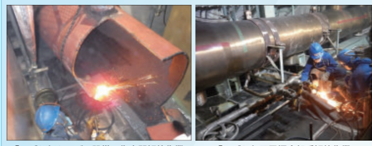
「ふげん」タービン設備・復水器解体作業 「ふげん」原子炉冷却系解体作業
